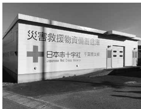
災害救援物資拠点倉庫
