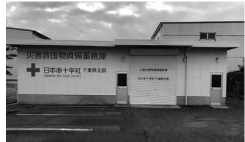
災害救援物資拠点倉庫
