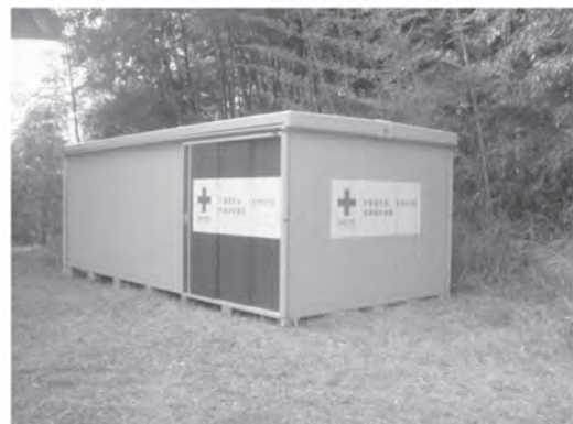
地区分区に設置された災害救援物資等保管倉庫
