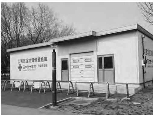
災害救援物資倉庫
