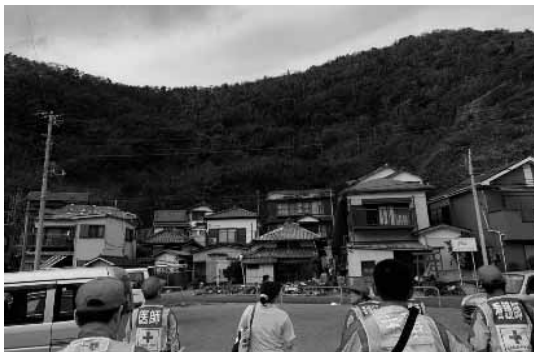
台風15号により屋根等が一部損壊した家屋
