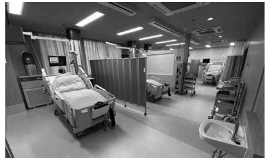
改修した HCU (高度治療室)
