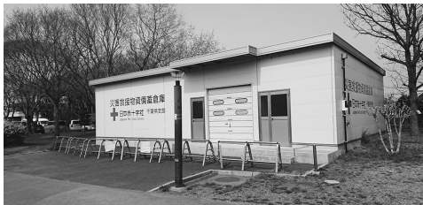
災害救援物資倉庫
