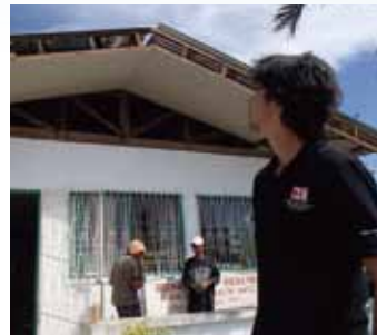
工事の進行管理を行うベティート係長
