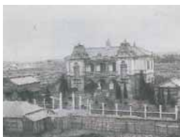
支部最初の社屋(明治36年竣工)
