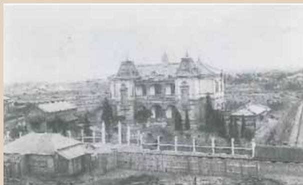
支部最初の社屋(明治36年竣工)
