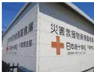
災害救援物資拠点倉庫
