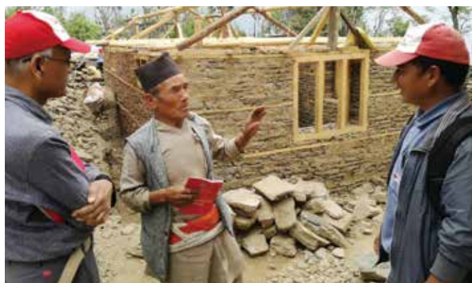
地震で全壊した住居の再建を支援（ネパール地震救援・復興支援 2015年～）
