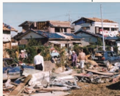
竜巻による被害状況
