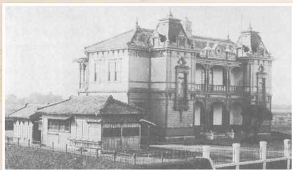
最初の支部社屋(明治36年竣工)
