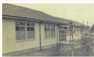
移転当時の病院全景
